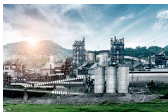
Stavební hmoty přeprava cementu potřebný tlak 4 bar
